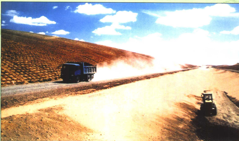
沙漠渠道开挖沙垄草方格防护
