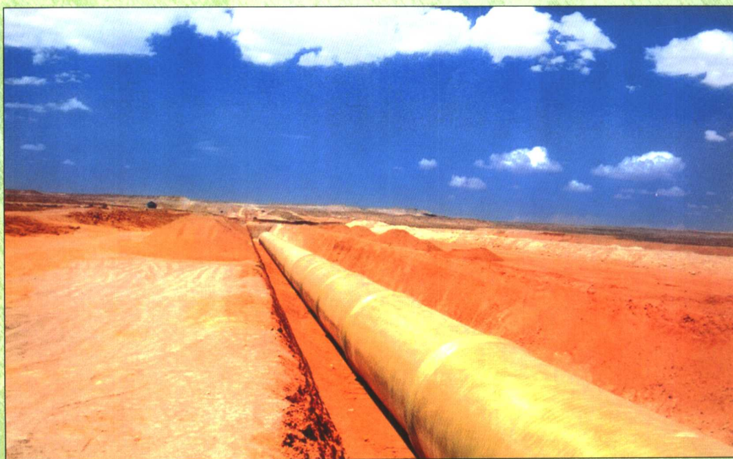
沙漠明渠倒虹吸工程玻璃钢夹砂管道铺设施工
