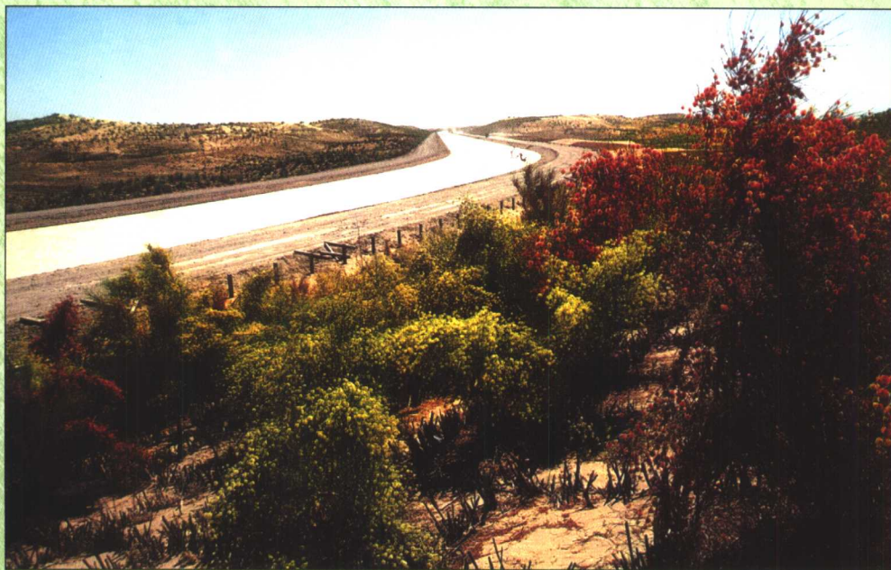
沙漠渠道治沙生态示范区
