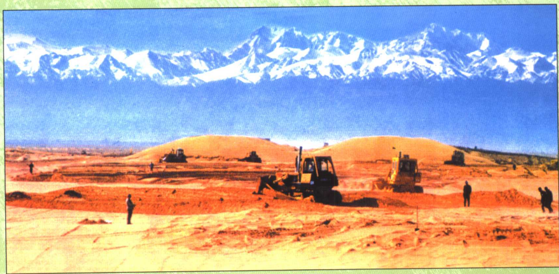
沙漠明渠高填方段施工
