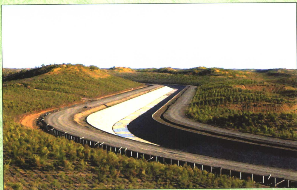
已建成的沙漠渠道工程
