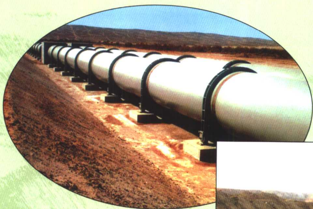
沙漠明渠倒虹吸工程预应力钢筒混凝土管道施工
