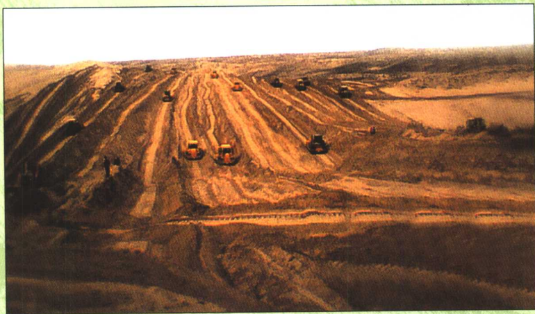
沙漠明渠填方段施工
