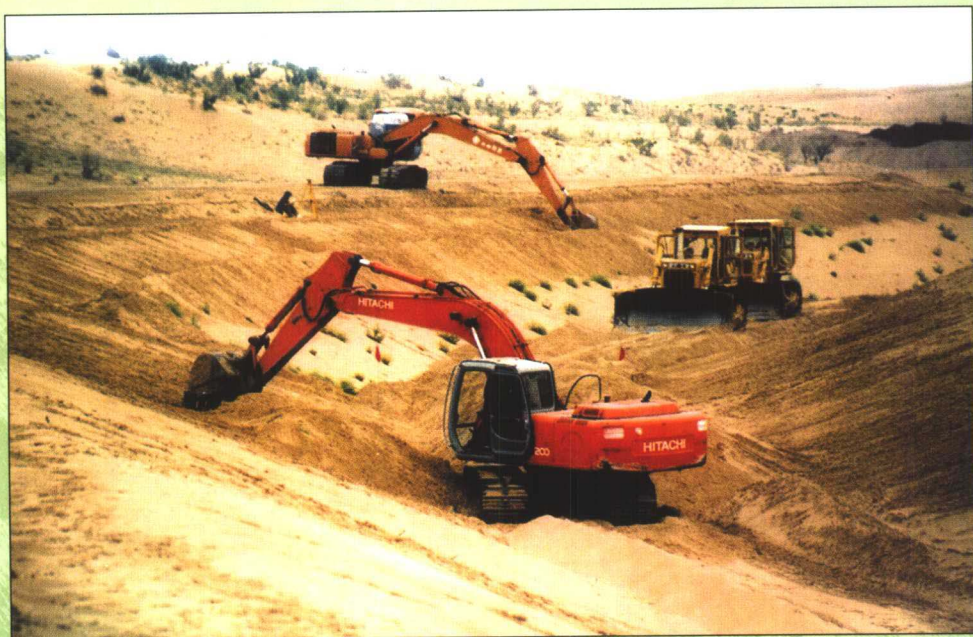
沙漠渠道开挖
