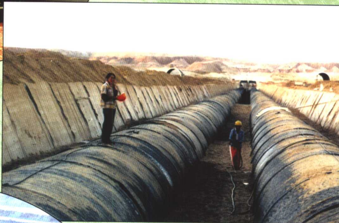
沙漠明渠倒虹吸工程预应力钢筒混凝土管道施工
