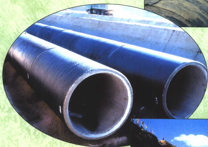
倒虹吸进水闸安装就位尚未浇筑混凝土的玻璃钢夹砂管道 (FRP)
