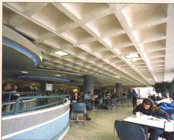
彩图 1-22 快餐厅：顶部喷 K-13 吸声材料
