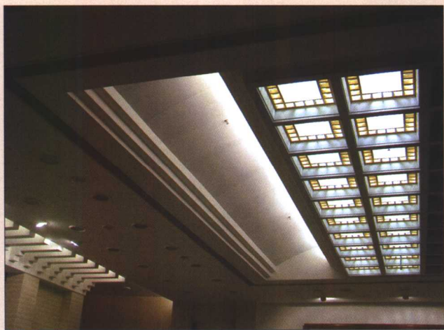
彩图 3-2 外交部谈判大厅：凹弧形吊顶为卡罗姆吸声材料
