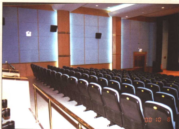
彩图 1-7 上海永乐电影电视公司放映厅： 墙面为软包装饰吸声板
