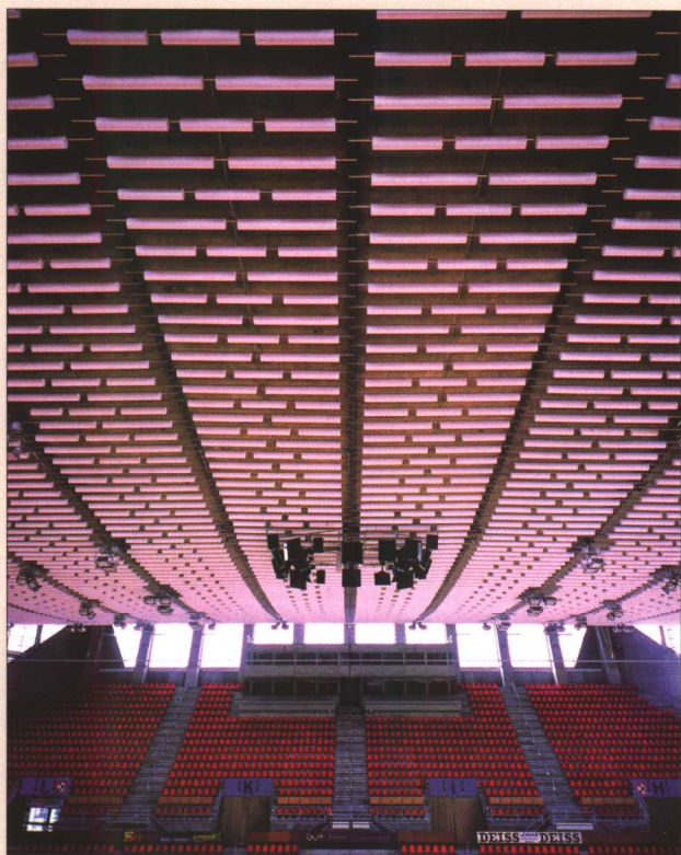
彩图 1-10 体育馆：顶部为音必克® YBK-BS 材料柱型吸声体
