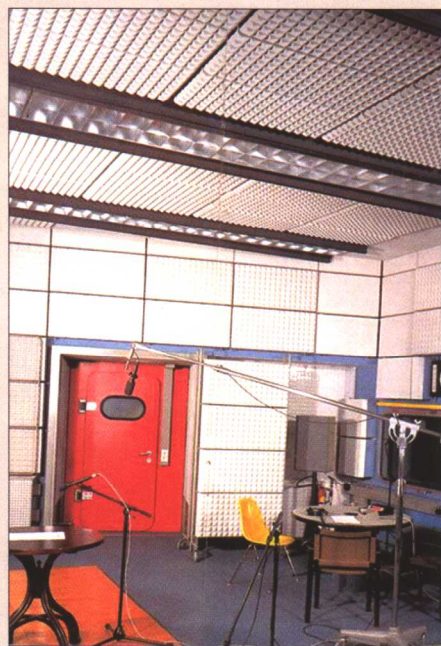
彩图 1-11 录音室：墙面和顶部为音必克® YBK-BS 吸声板
