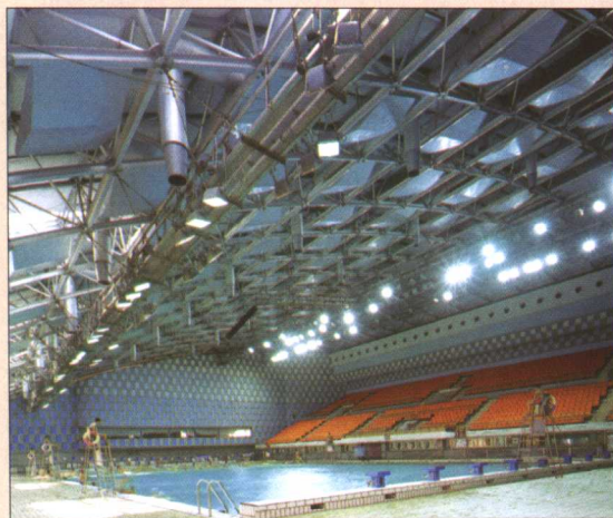
彩图 3-4 上海浦东游泳馆： 铝板穿孔折板式吸声体
