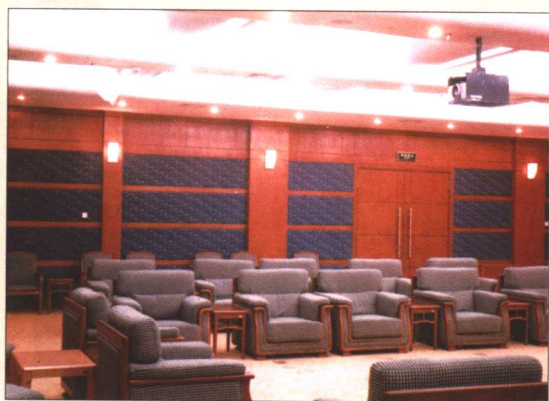
彩图 1-6 中共中央党校会议室： 墙面为软包装饰吸声板
