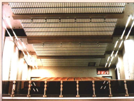
彩图 1-13 某剧场：顶部为音必克® YBK-BS 吸声板
