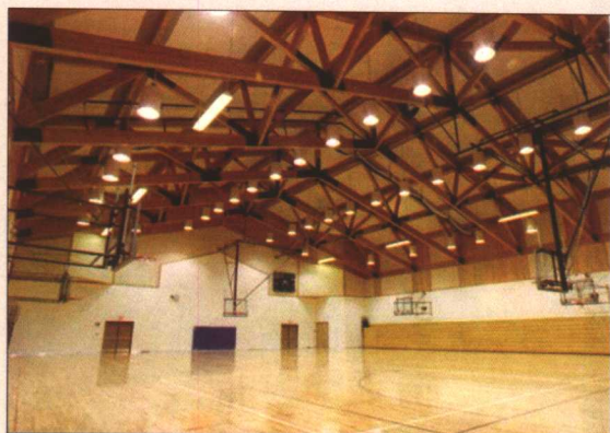
彩图 1-14 体育馆：顶部喷 K-13 吸声材料
