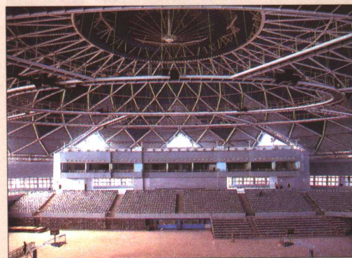
彩图 3-8 新疆乌鲁木齐体育中心体育馆： 网架内悬吊片式吸声体
