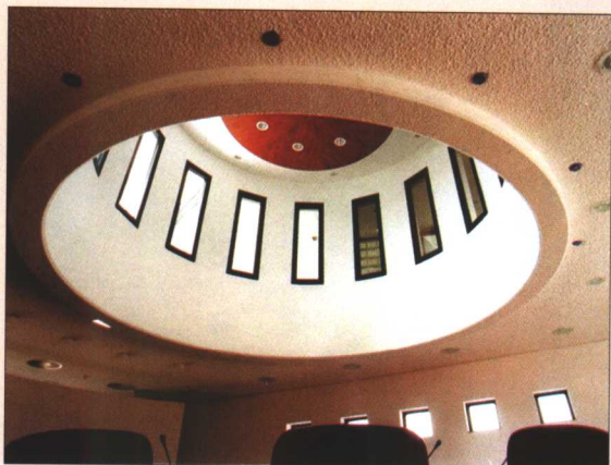
彩图 1-20 教堂：顶部喷 K-13 吸声材料
