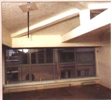
彩图 1-30 TC 系列纤维喷涂工程实例
