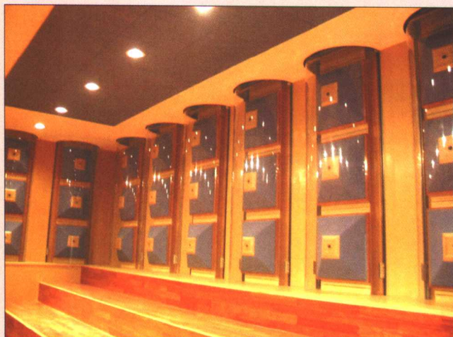
彩图 1-38 大连广电中心录音棚： 墙面为有升降玻璃罩的宽频复合吸声体
