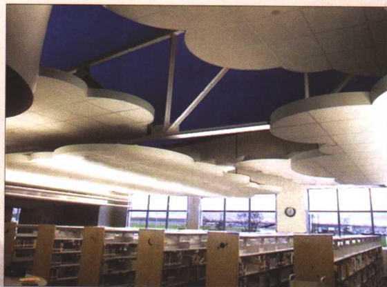
彩图 1-25 阅览室：顶部喷 K-13 吸声材料
