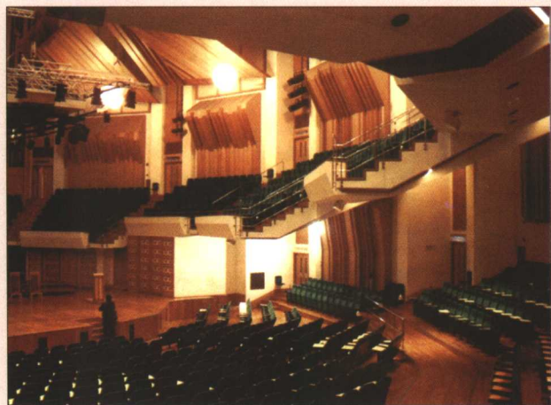
彩图 4-6 香港文化中心音乐厅：大厅两侧使用侧向反射板，反射板表面采用 QRD 扩散构造
