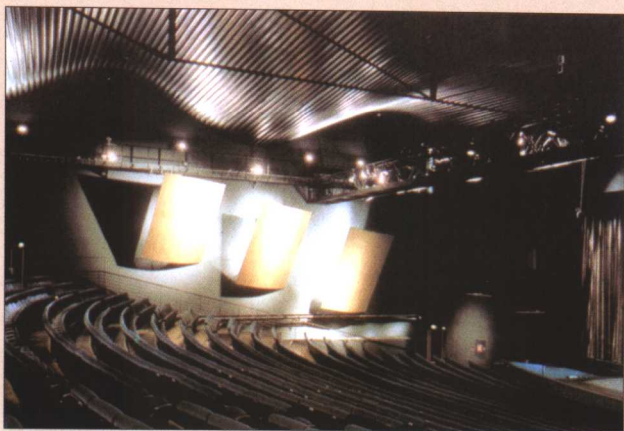
彩图 4-2 美国达拉斯麦克德莫特音乐厅: 顶部反射板重达 42t, 可升降和调节倾角
