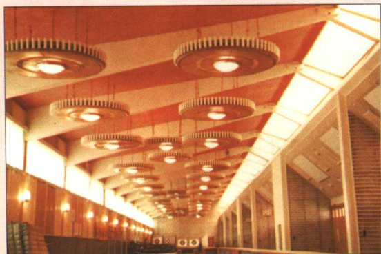
彩图 3-7 北京手枪靶场：场内悬吊圆盘形宽频带空 间吸声体
