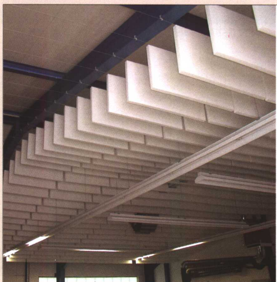
彩图 1-12 德国啤酒厂车间：顶部用音必克® YBK-BS 板式吸声体减噪
