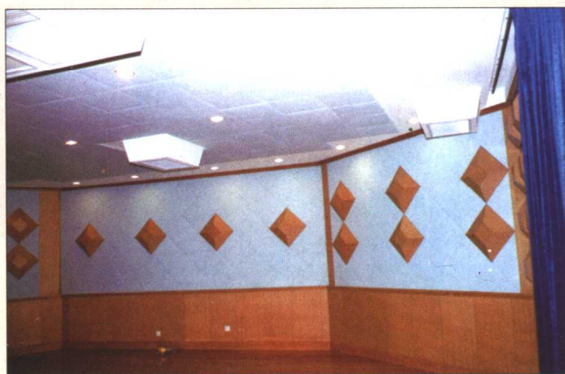
彩图 1-2 大连广电中心配音室：墙面和吊顶为软包装饰吸声板
