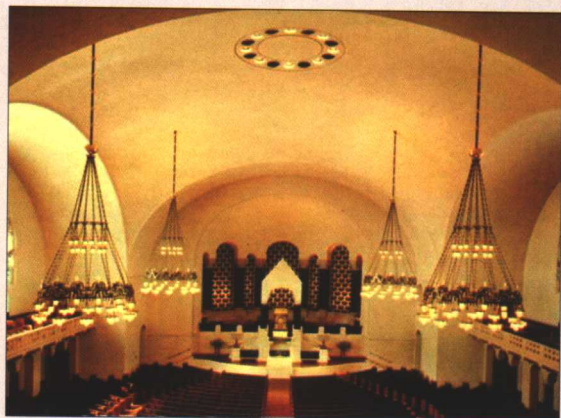
彩图 1-21 教堂：顶部喷 K-13 吸声材料
