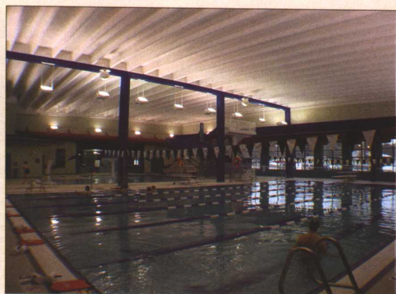
彩图 1-15 游泳馆：顶部喷 K-13 吸声材料
