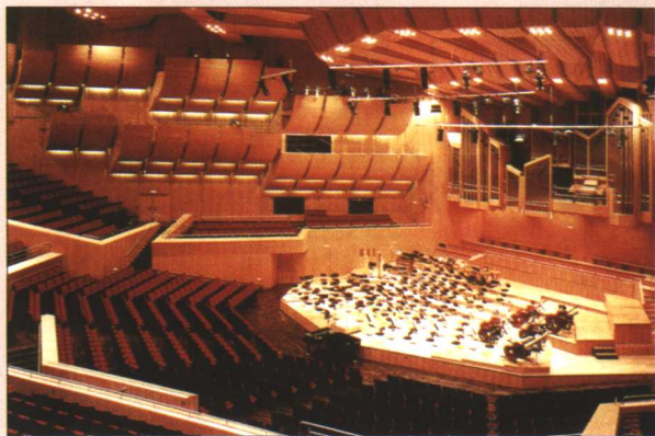
彩图 4-5 德国慕尼黑：加施泰许音乐厅：侧墙上的弧形扩散板、吊顶的折线造型以及不规则的大厅体型都有声扩散的作用
