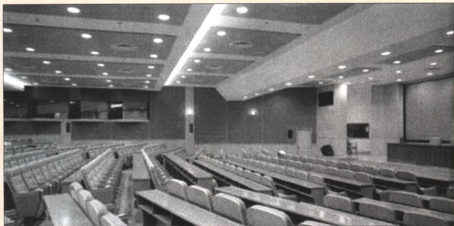
彩图 1-1 国家行政学院会议厅：墙面和吊顶为软包装饰吸声板
