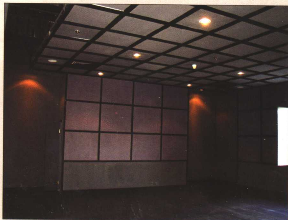
彩图 1-9 首都剧场小观众厅： 墙面和吊顶为软包装饰吸声板
