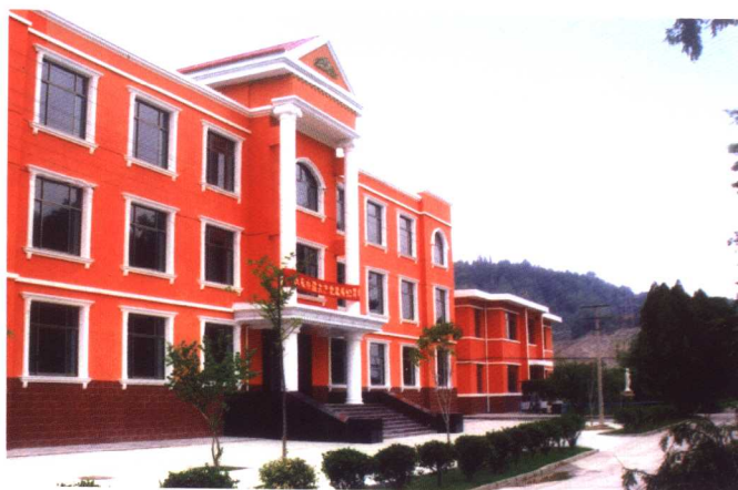
甘肃省地震局监测台站经过“十五”的改造,面貌焕然一新,图为兰州观象台外貌
