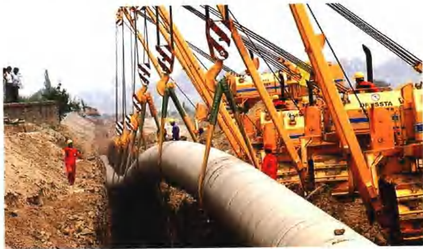
2004年12月30日，西气东输全线正式投入商业运营。西气东输工程从祖国西部的塔里木气田起步，长驱东去。一直到东部的长江三角洲地区，以年输天然气量200亿立方米，稳定供气30年的庄严承诺，担负起了拉动西部经济发展，改善东部能源消费结构，促进东西部经济、社会、环境协调发展的重任。图为西气东输工程天然气管道整体吊装下沟场景。
