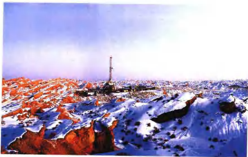
2004 年，塔里木盆地已累计探明天然气地质储量 6600 亿立方米，具备了为西气东输稳定供气 30 年的资源基础
