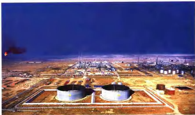
中国石油哈萨克斯坦阿克纠宾项目全年原油产量 532 万吨。图为扎那诺尔油气处理厂
