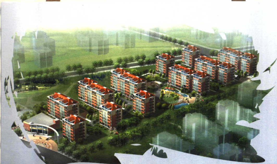
正在开发中的「紫荆馨苑」小区
