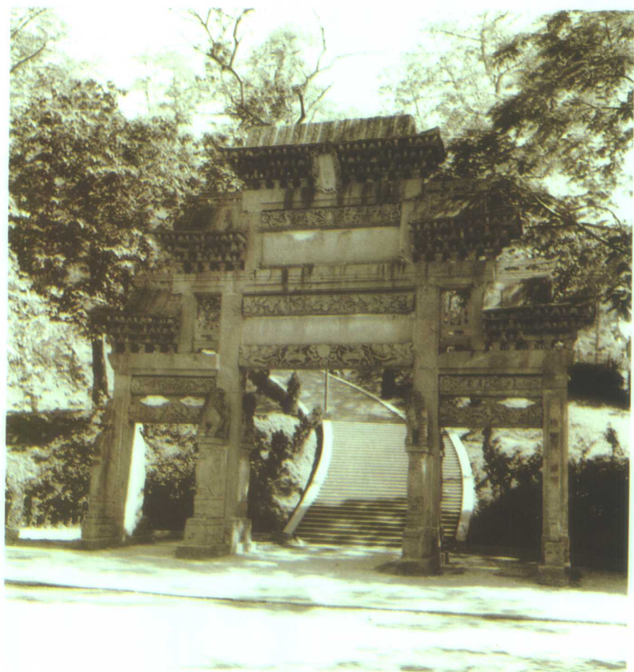
百步梯东入口的明代牌坊（越秀公园前石牌楼）
