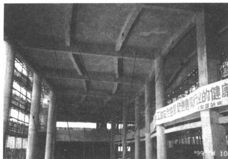
结构柱 结构楼 板结构梁
