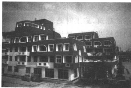
图 2-3-2 某混合结构养老院
