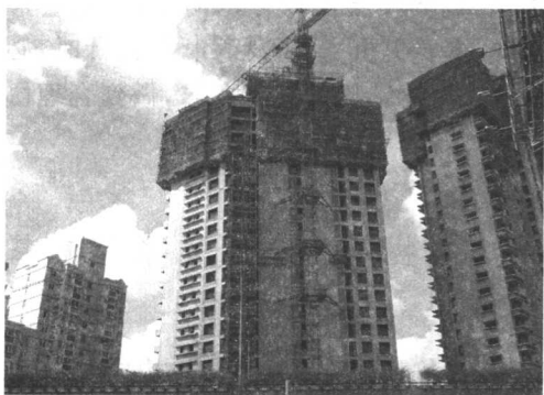
图 2-3-4 施工中的现浇钢筋混凝土承重墙结构住宅
