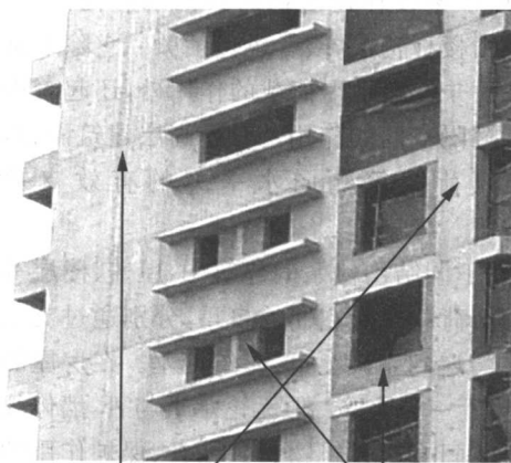
承重结构 围护结构 围护结构
