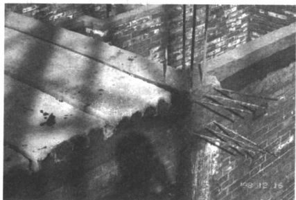
图 2-3-1 施工中的多层混合结构建筑
