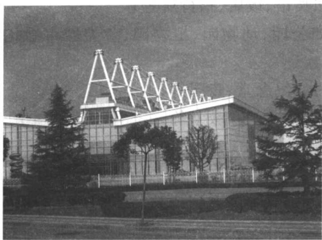
图 1-1-1 某工业厂房(生产性建筑)
