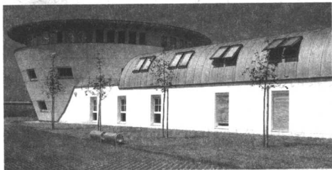
图 2-1-4 建筑物屋盖及门窗
