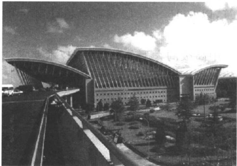
图 1-1-4 某机场候机楼(公共建筑)
