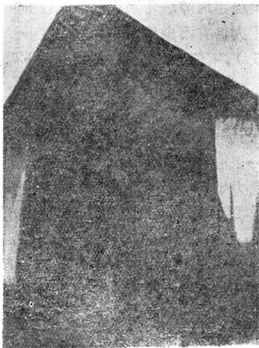
图 7 容积为 54000\text{m}^3 的湿式貯气柜
