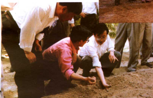
商丘地区交通局领导检 查县乡公路工程质量
