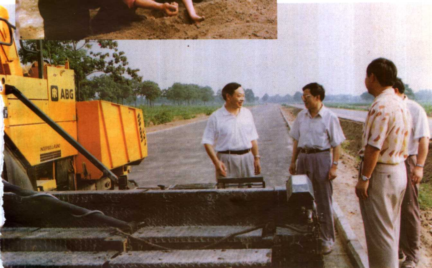
商丘地区交通局领导视察 105 国道商丘南段大修工程
