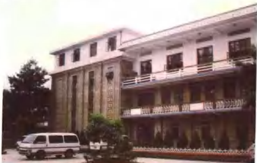
江口镇人民政府办公大楼
