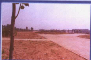
建设中的南湖公园
