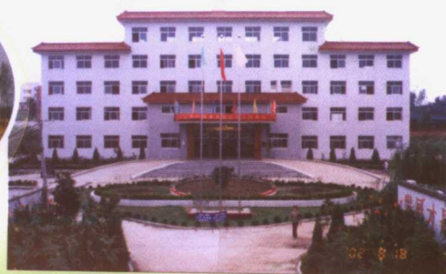
镇卫生院大楼
