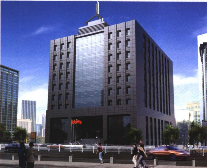
北京市司法局大楼
