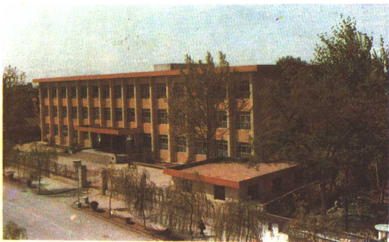
▲ 山东省图书馆新扩建的阅览办公大楼，总面积五千平方米，内设七个阅览室，于一九八四年九月开放。
