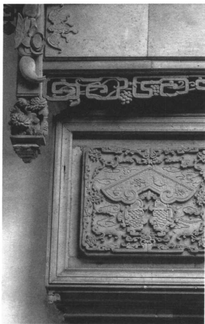
图 12 砖雕门楼仿木的垂花、挂落装饰构件。
