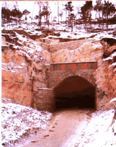
► 遵化县地方道路上的隧道
