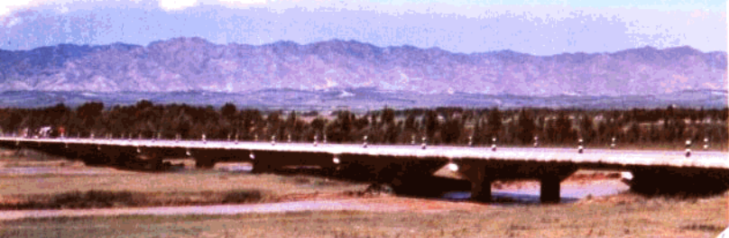
▲ 锡海公路阳原桑干河漫水桥
