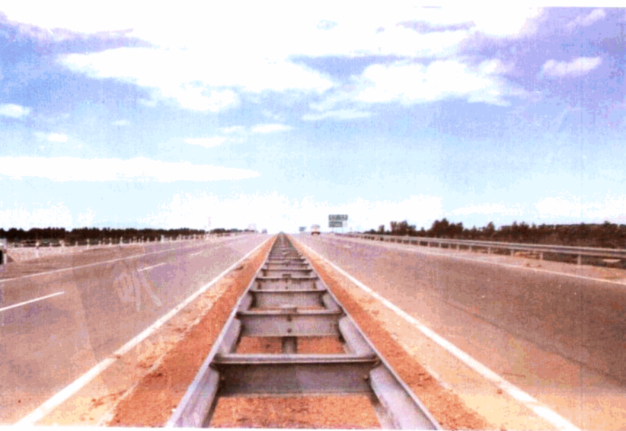
▲ 河北省第一条单幅高速公路——京深公路京石段
