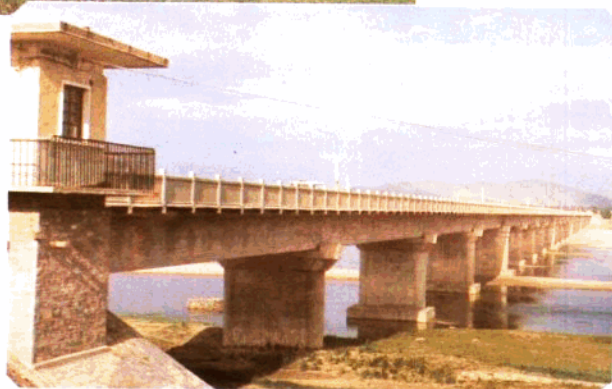
承德——滦平山公路滦河钢筋混凝土撑架连续板梁特大桥
