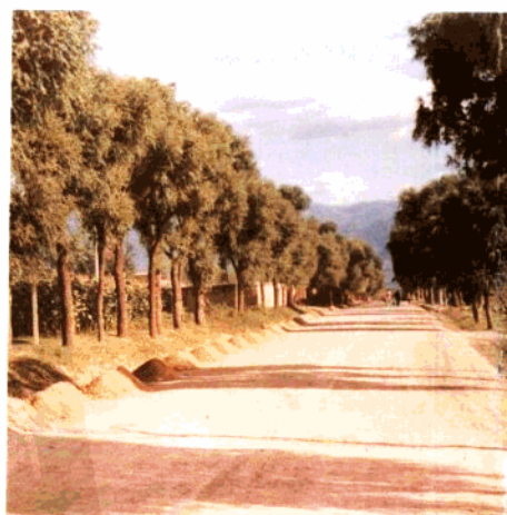
▲ 蔚县——广灵公路蔚县粒料路面
