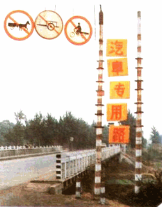
► 河北省第一条二级汽车专用公路 ——京深公路邯郸马头段
