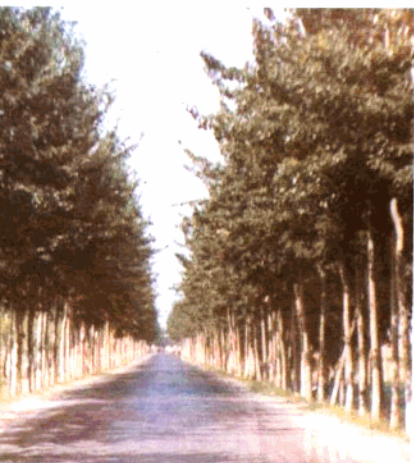
▲ 岐银公路深县段沥青(渣油)路面
