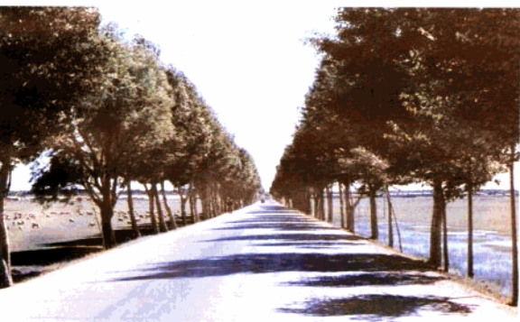
▼ 张家口——沽源公路张北段绿化情况
