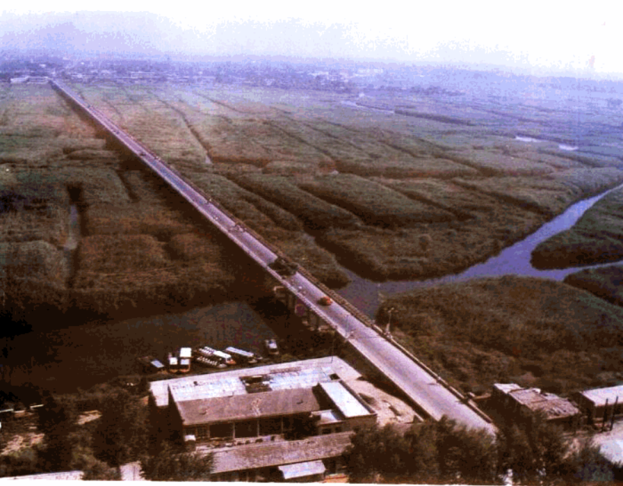
▲ 河北省最长的钢筋混凝土桥——保新公路安新县白洋淀特大桥
