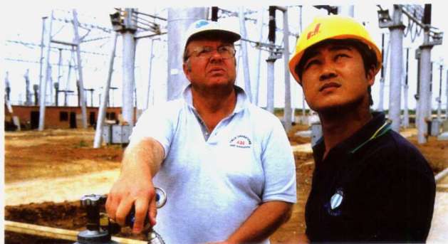
ABB 公司专家 在洛阳 500 千伏牡丹变电站工地指导工作
