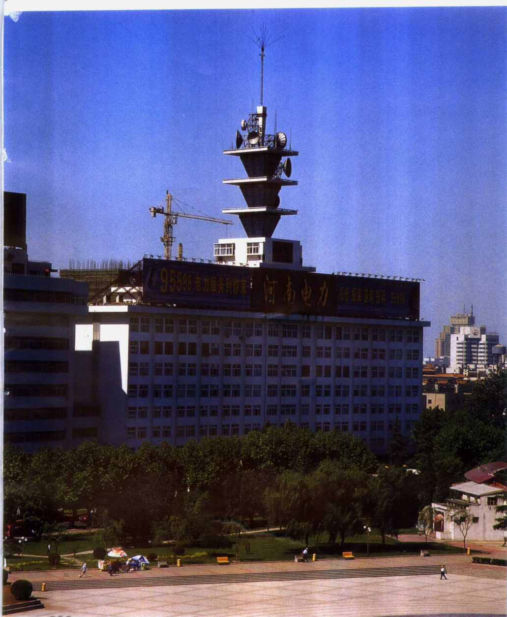
河南省电力调度大楼
