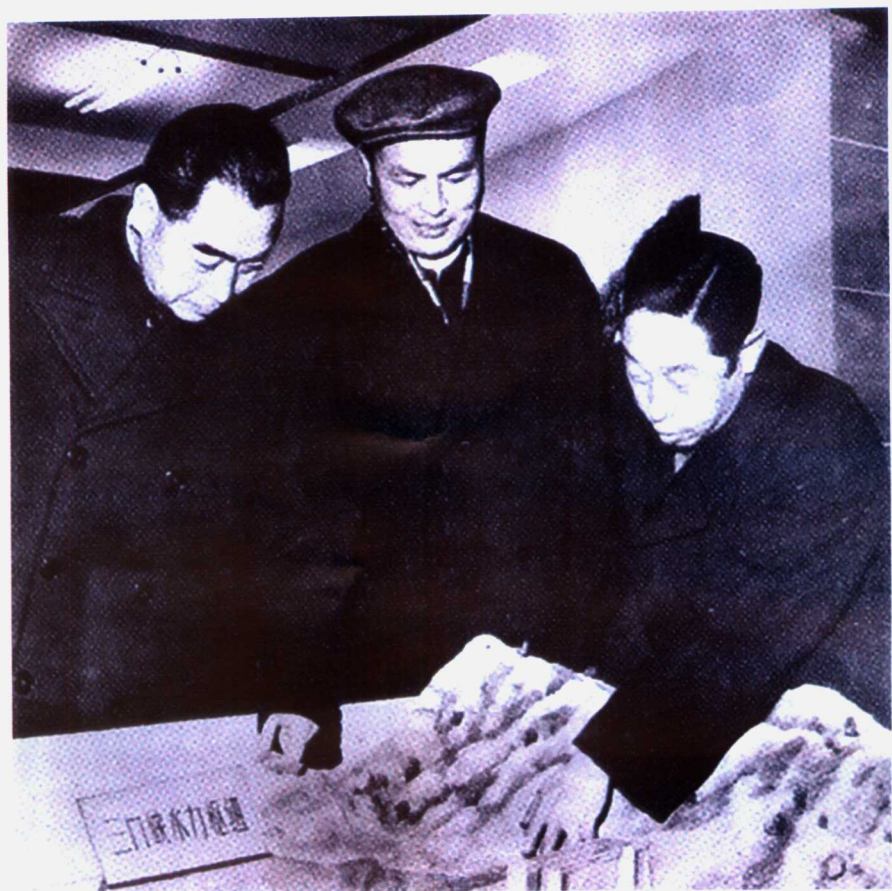
周恩来总理（左一）视察三门峡水利枢纽工程
