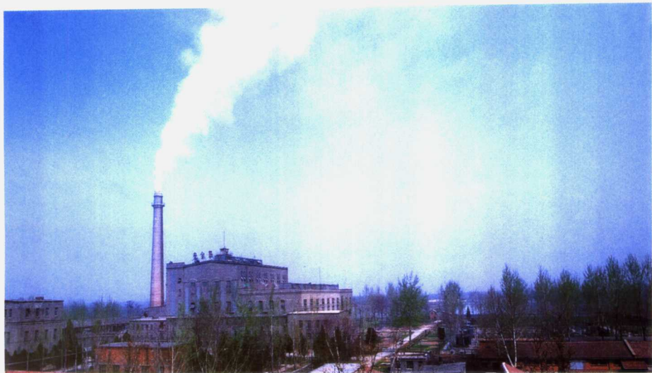
新中国成立后的河南第一座国家重点建设项目——郑州火力发电厂 ( 2 \times 0.60 万千瓦)
