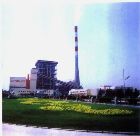
利用亚行贷款建设的禹州电厂 ( 2 \times 35 万千瓦)
