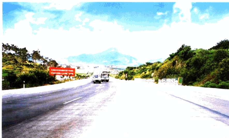
福厦公路(324 国道)郊尾路段
