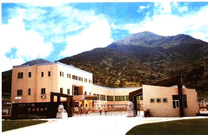
500千伏莆田变电所
