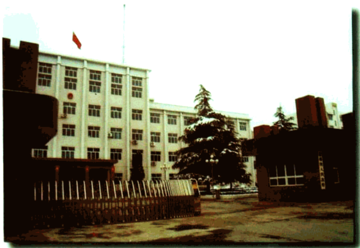
市政府办公大楼
