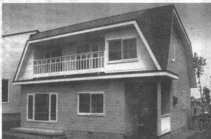
图 1-4 以水泥刨花板建成的低层住宅
