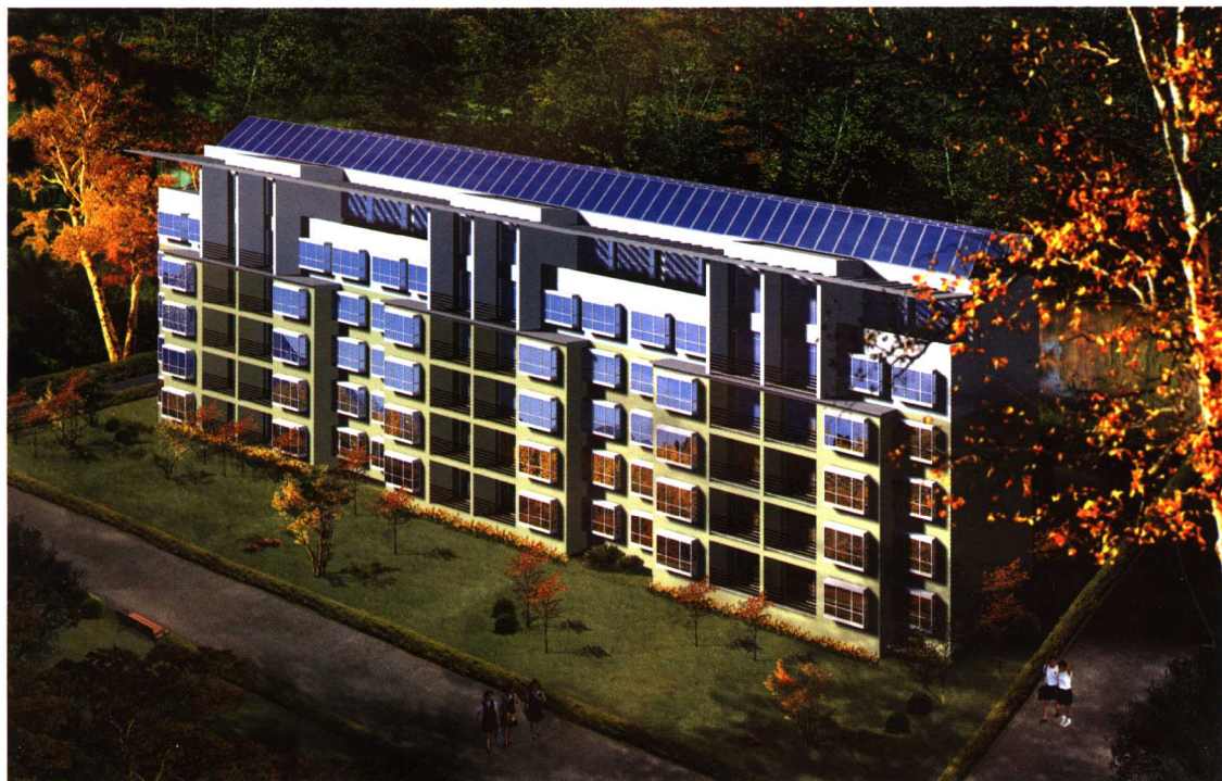
彩图 2 天津某小区平屋面多层住宅
