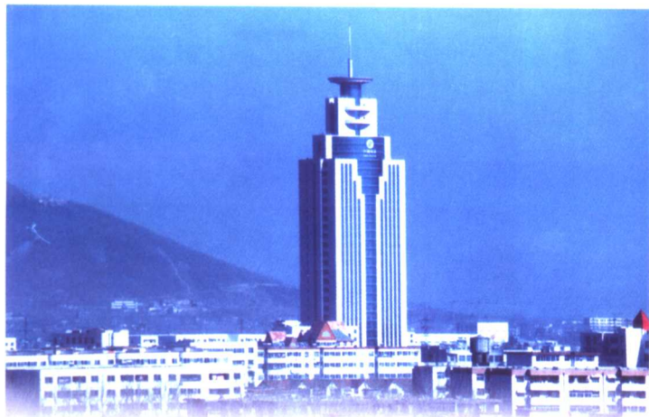
南阳电信大楼
