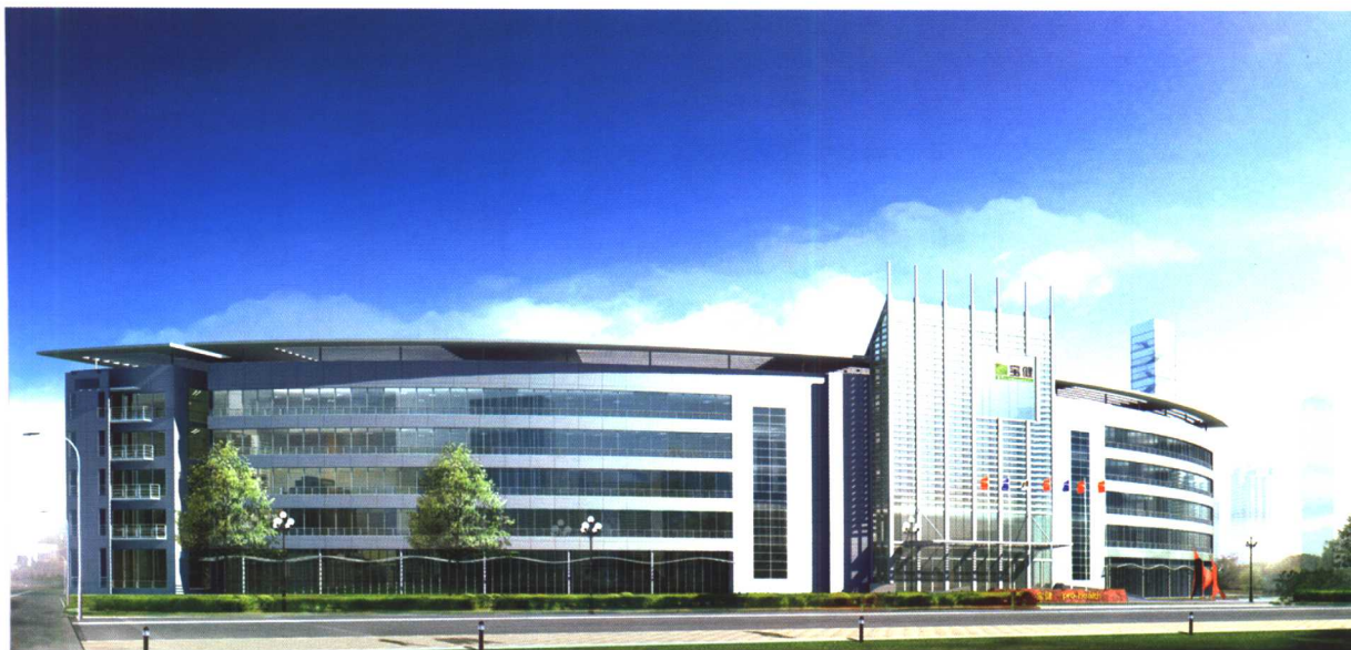
↓ 宝健公司在北京亦庄投资新建的运营总部
