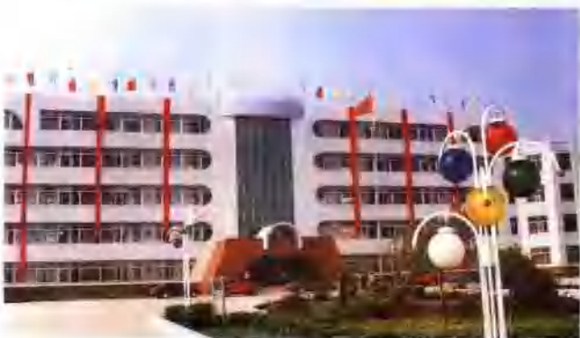
市二十八中教学大楼
