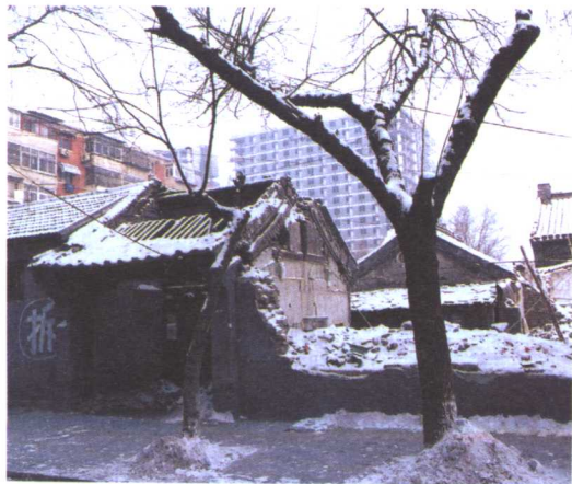
正在拆除的院落
