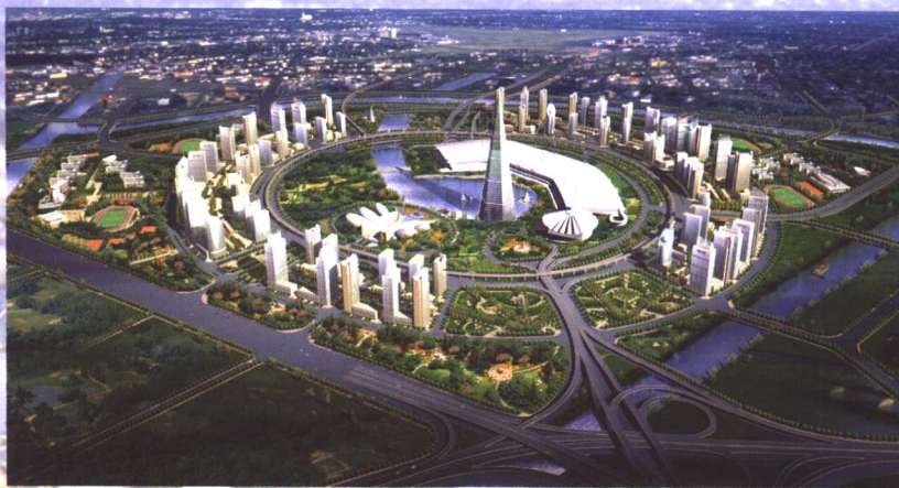
正在建设中的郑东新区CBD远景
