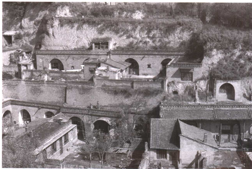
山西灵石县窑洞建筑
