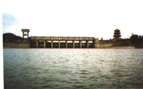
升钟水库溢洪道
