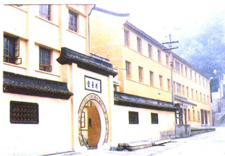
新建佛教安养堂养老院门景
