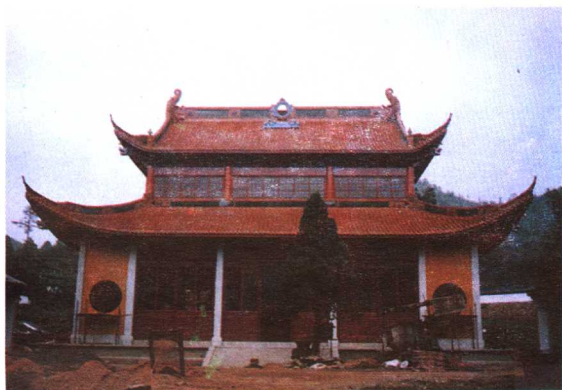
建设中的径山寺大雄宝殿
