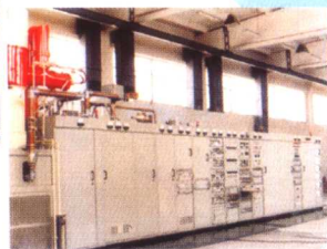
彩图0-27 北京正负电子对撞机的强大功率高频发生器（功率电源）
