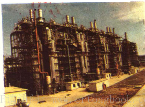
▼ 上海30万吨 乙烯工程
