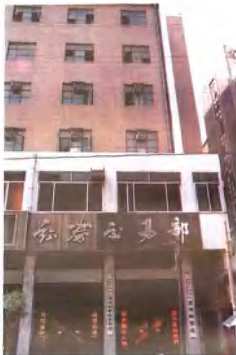
▲市工商银行漯河市信托投资公司 办公大楼
