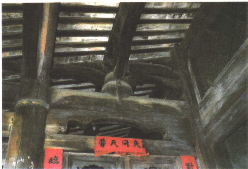
施琅故宅大厅的天井。
