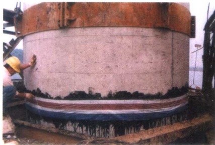
25. 连接完毕的桩节
