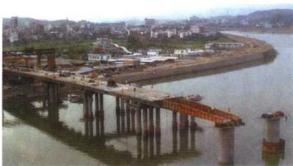
10. 广东韶关五里亭大桥
