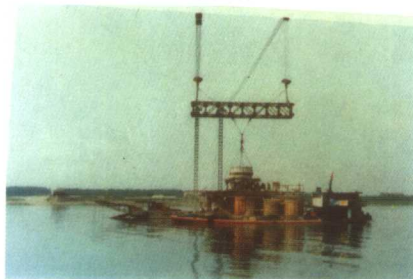
6. 空心桩缆吊吊运拼接全景
