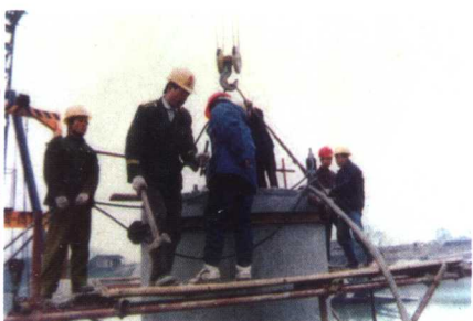
30. 桩内注水下沉
