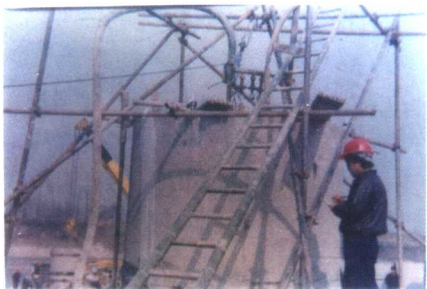
19. 压浆测读上抬量、压力
