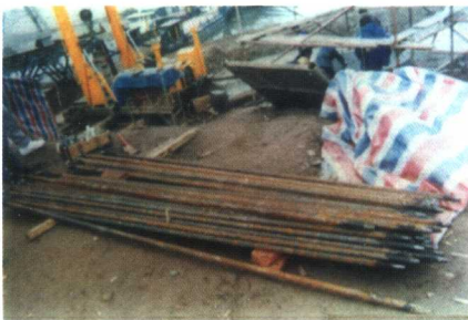
22. 接头用 \Phi 32 锥形连接筋
