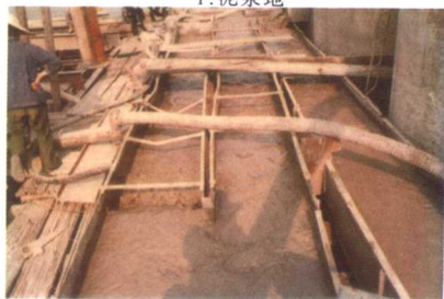
3. 在钻孔中采用的油由聚内烯酰胺不分散低固相浆系统
