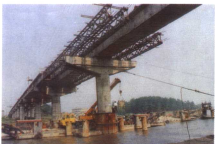
13. 湖南南县哑吧渡大桥
