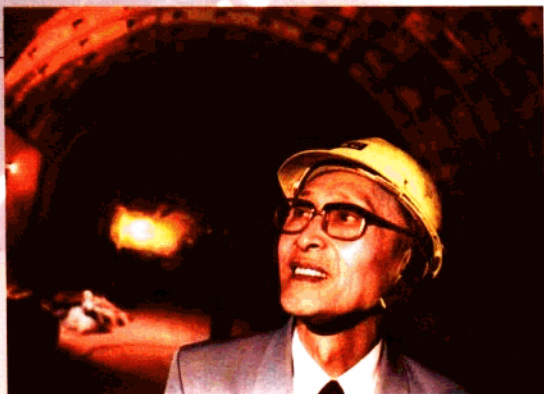
中国工程院院士刘建航在隧道工程施工现场。
