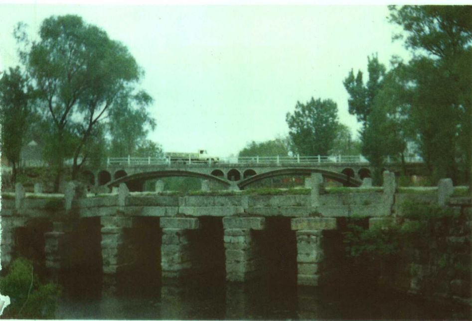
和尚桥及人民路桥
