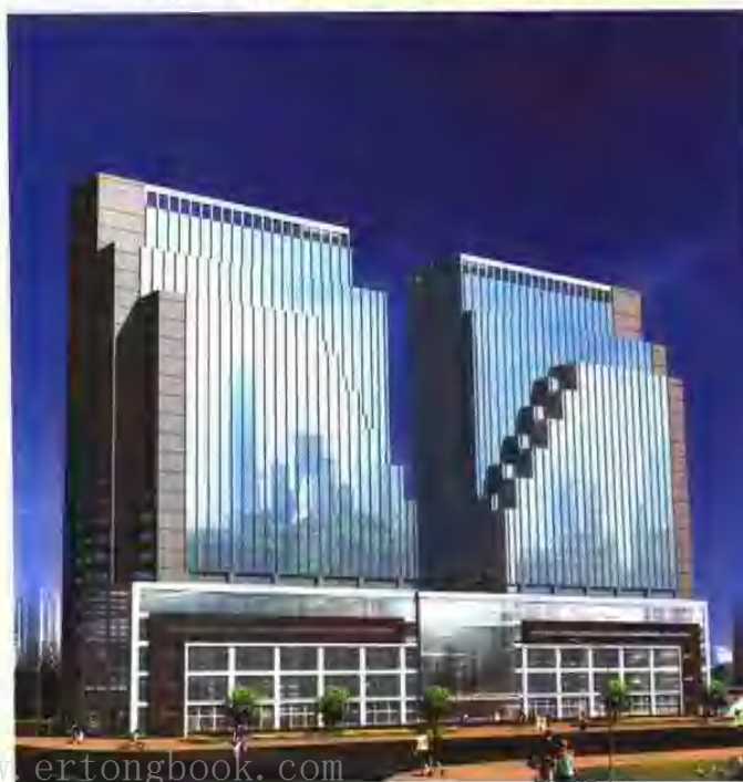
建设中的新疆乌鲁木齐人民广场联合大厦
