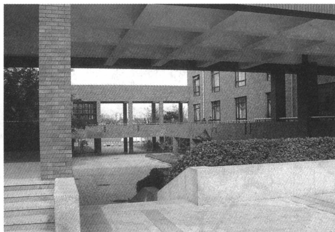
教学主楼南部庭院通道
