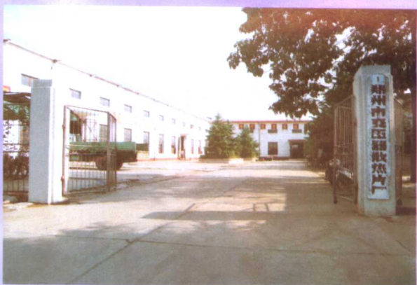
十里铺村变压器散热片厂
