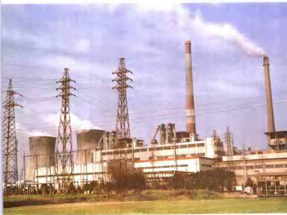
1993 年全部改建后的戚墅堰发电厂
