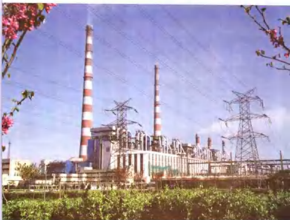
1987年全国最大的火力发电厂——谏壁发电厂
