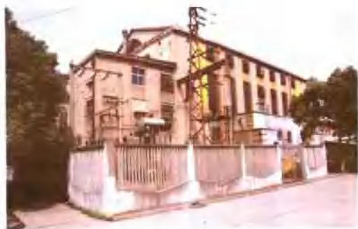
66 千伏的苏南电网中主要发电厂之一的戚墅堰发电厂
