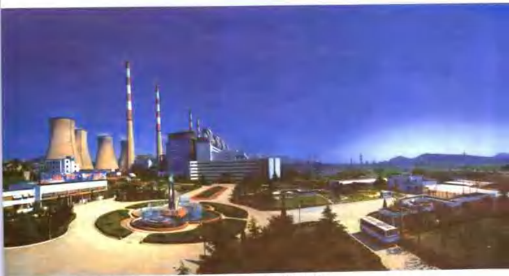
1987年江苏最大的坑口发电厂——徐州发电厂
