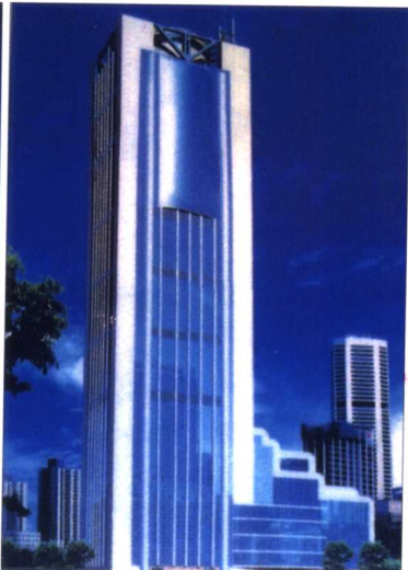
本公司承建的上海中心广场玻璃幕墙、铝板幕墙工程
