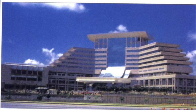
本公司承建的深圳五洲宾馆（国宾馆）玻璃幕墙、铝板幕墙、全玻璃墙、光棚和门窗工程
