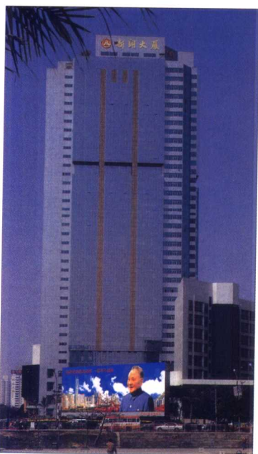
本公司承建的深圳新闻大厦玻璃幕墙、铝板幕墙和铝窗工程
