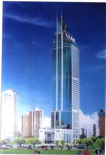
本公司承建大连云山大厦玻璃幕墙、铝板幕墙和全玻璃幕墙工程
