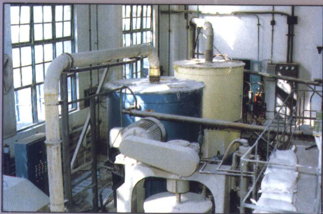
实验工厂——硅氮化生产线
