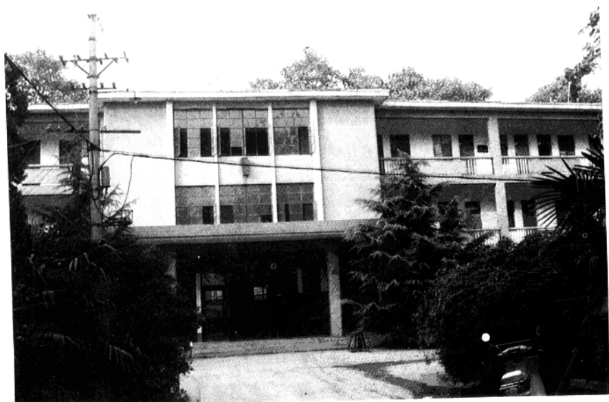
区委区政府办公楼
