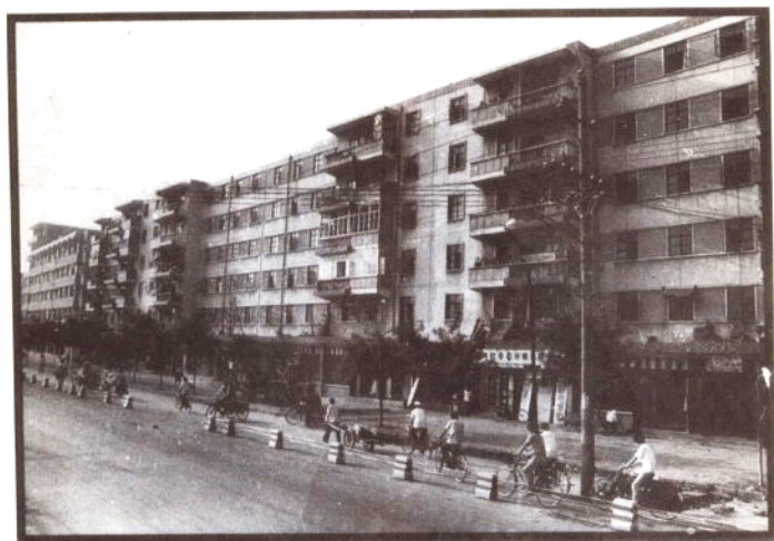
商丘市民主东路居民住宅楼
