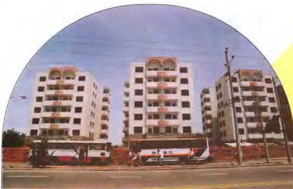
道路拆迁后新建的安置楼
