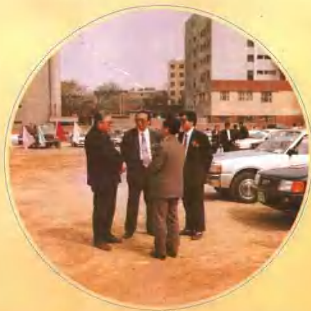
张德广等领导同志视察拆迁工地
