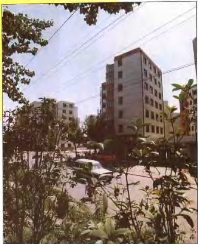
旧房拆迁后新建北闸口住宅楼
