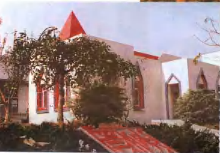
风格别致的建筑物
