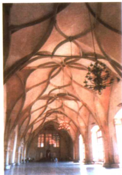
布拉格城(9世纪~)的12世纪会堂(银色大厅)。力流沿着石灰石建造的顶棚上的带状肋清晰地传递。虽然为石材,却柔和温暖。
