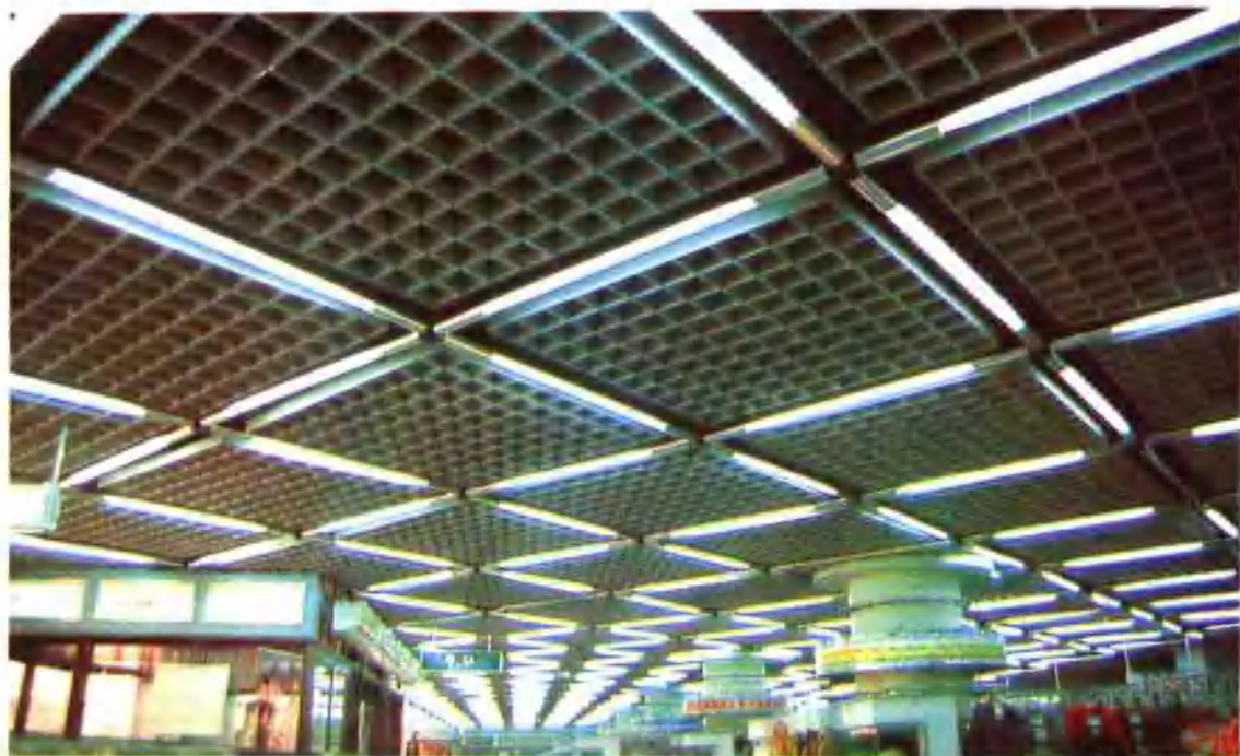
营业大厅的格栅吊顶与方格式布置的荧光灯照明
