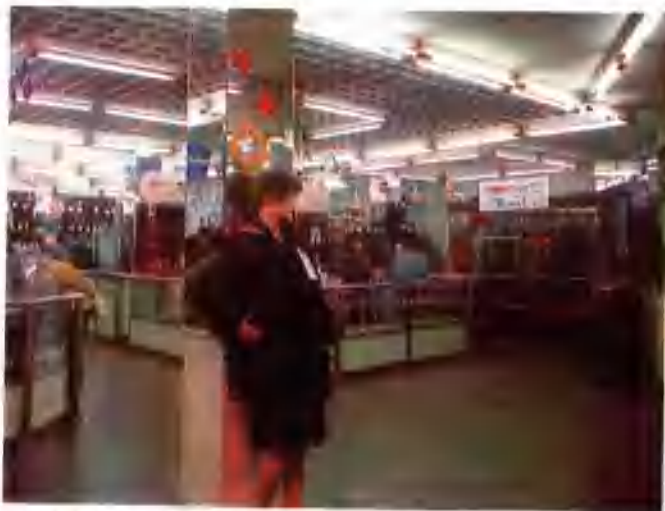
工作照明采用荧光灯, 柜台重点照明采用吊杆筒灯
