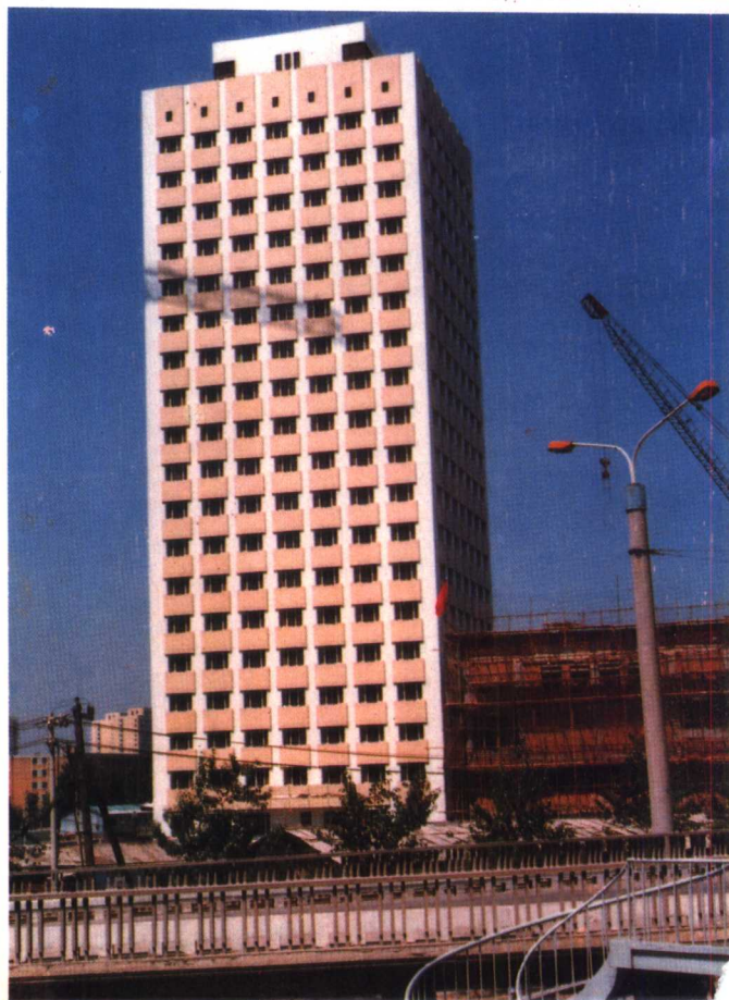
⑮正在建设中的国家医药管理 局
