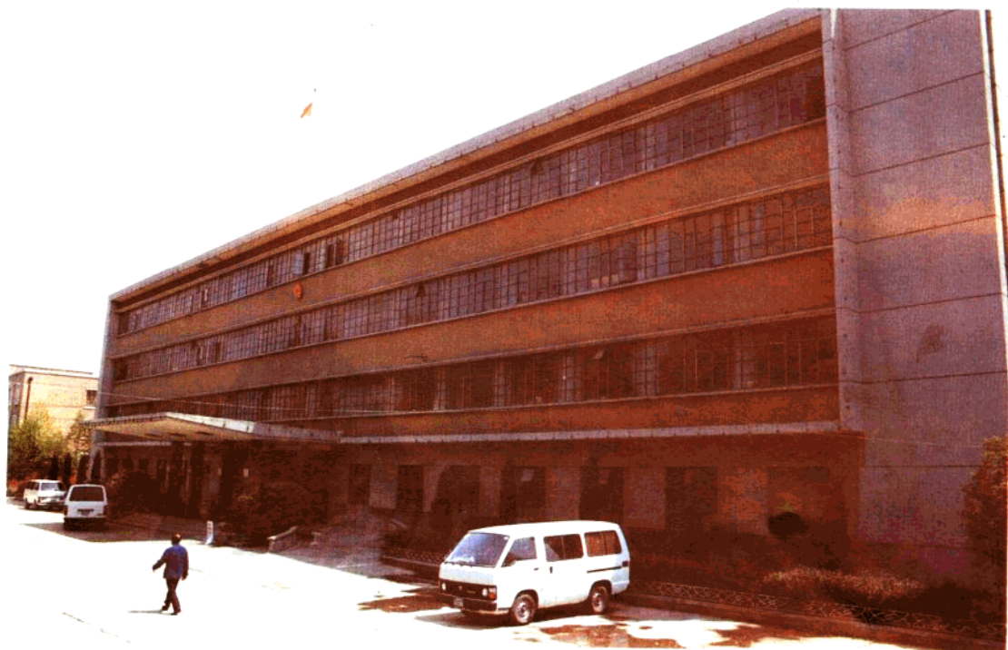
南阳市人民政府办公楼
