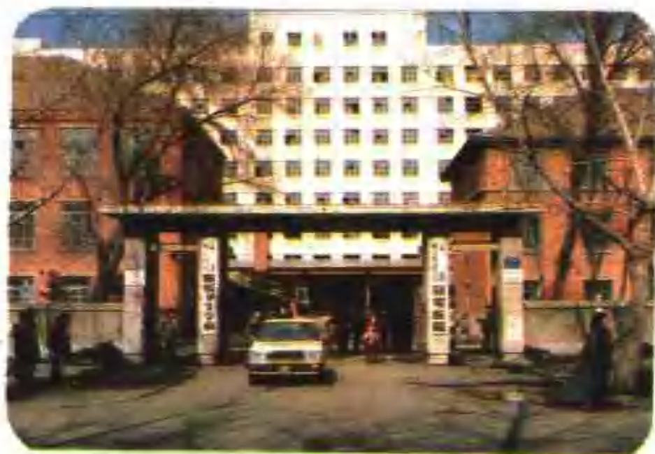
正在兴建的附属医院住院部大楼即将交付使用
