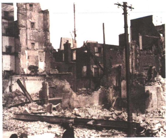
战争的炮火把原来美丽整洁的城市街区和楼房变成了一片片残垣断壁。
