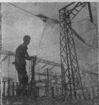
(2) 冲洗44千伏输电线路
